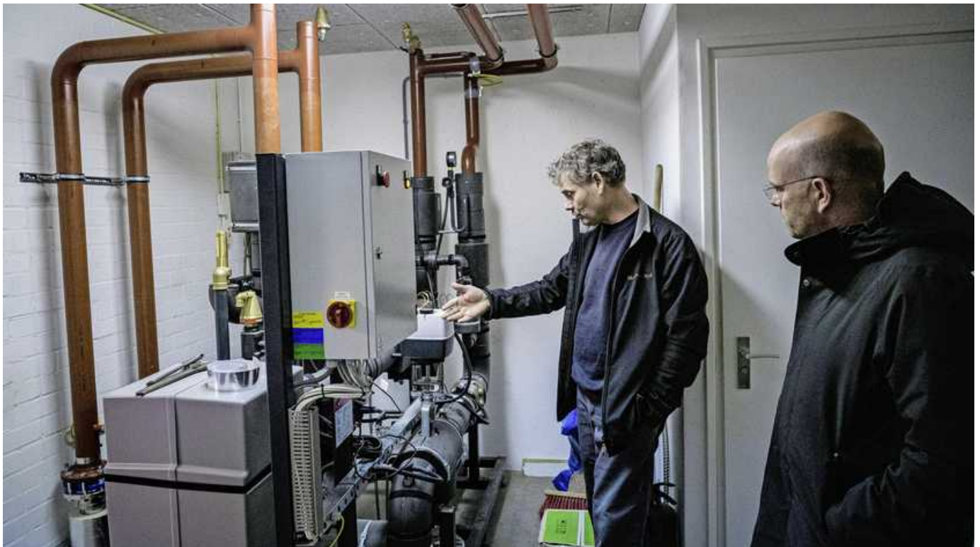
Aanleg van Warmtenet in de Groningse wijk Paddepoel.
